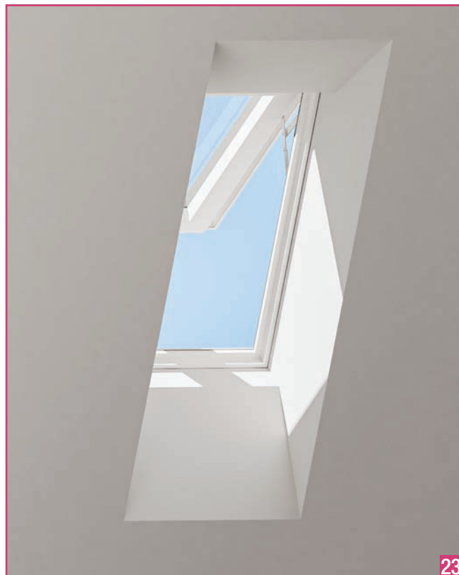
Cubrir las jambas con placas de yeso y preparar para el acabado final.
